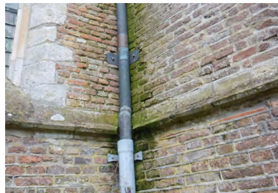
Verstopte hemelwaterafvoer
