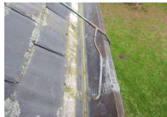
Loszittende bliksembeveiliging
