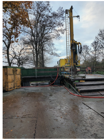
Opstelling van de boorwagen die tot ongeveer 145 meter onder de grond heeft geboord.
